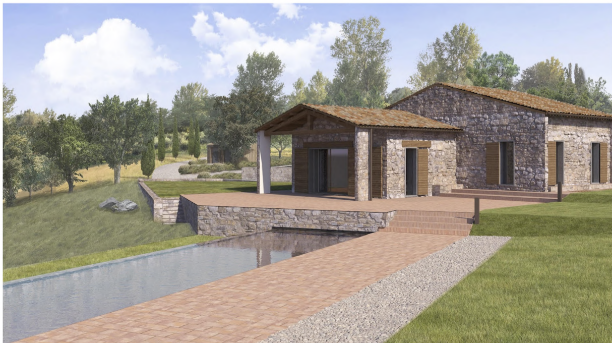
Landhaus in der Toskana (im Bau) | Projekt und Photo Credits - Atelier LVS
