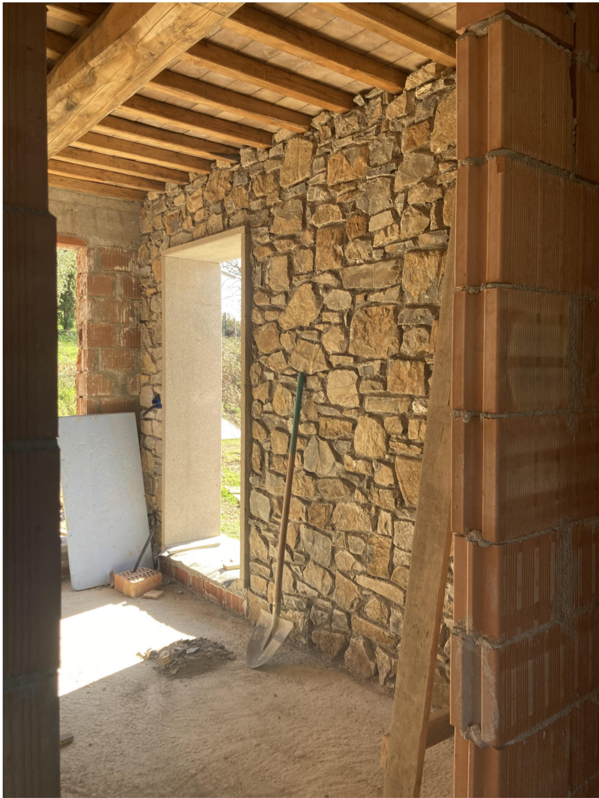
Landhaus in der Toskana (Baustelle) | Projekt und Photo Credits - Atelier LVS
